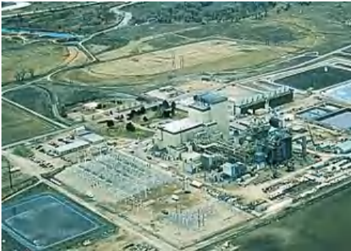
Fort Saint-Vrain, USA 300 MWe 1976-89
