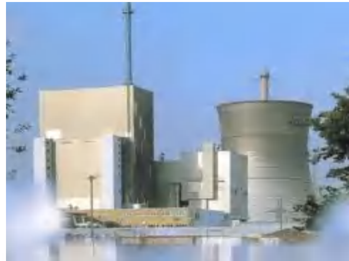
THTR, Niemcy 300 MWe 1986-89
